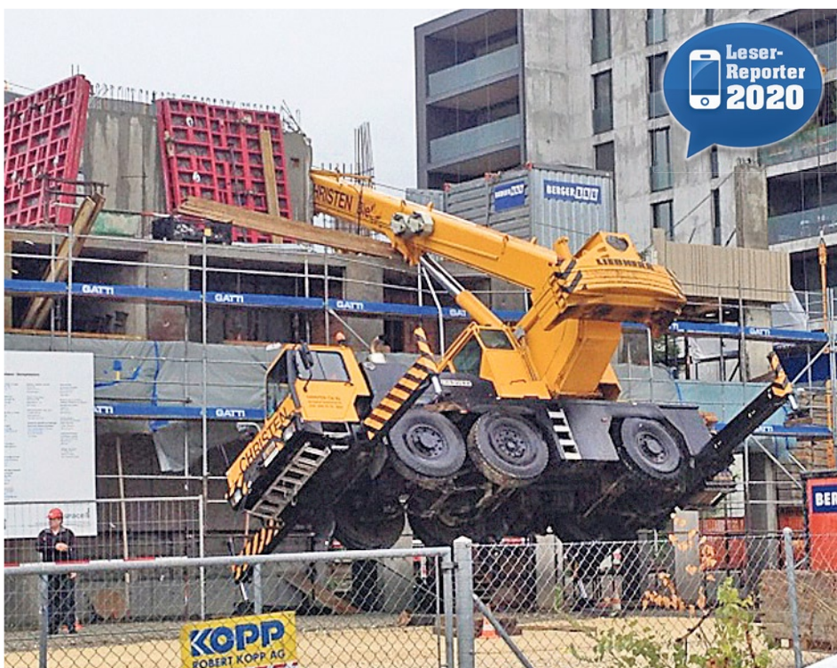
Dieser Hebekran beim Bieler Güterbahnhof hat sich wohl «übernommen» – oder wars der Wind?
