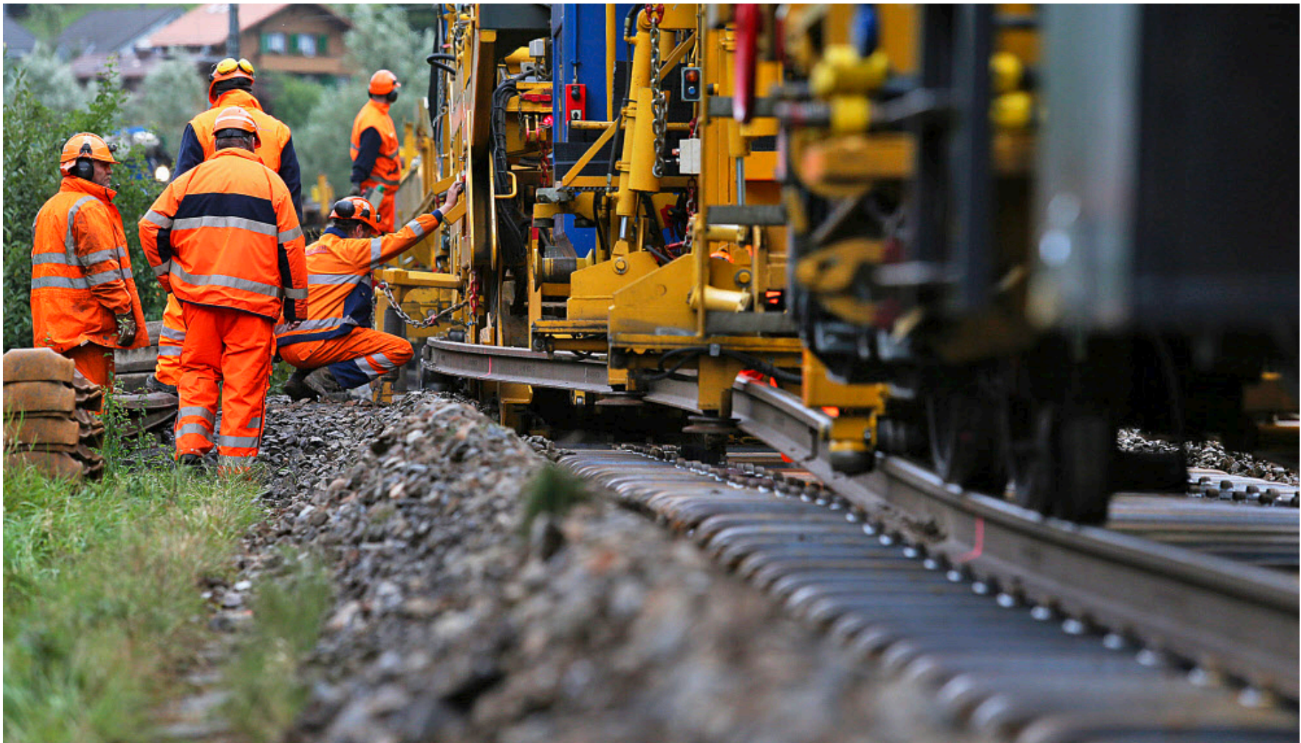
Der Bauzug Puma-S und die Bauarbeiter arbeiten bei Tag günstiger und effizienter, verspricht die BLS.
